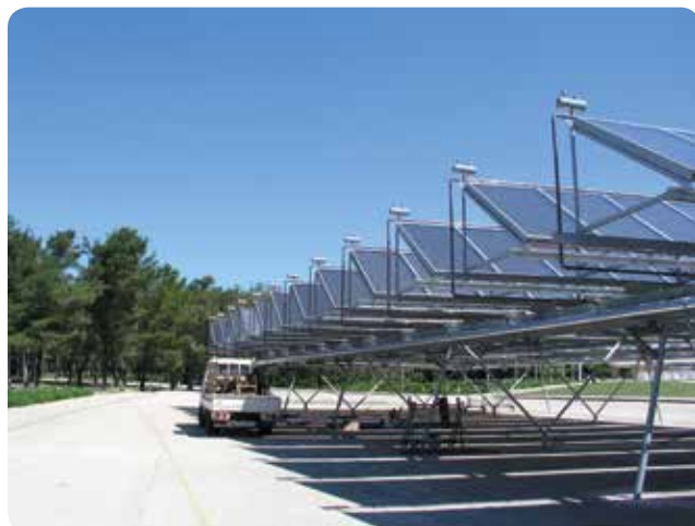
• AUTO KAMP ZATON KRAJ ZADRA – POSLJEDNIH 238 KOLEKTORA UGRAĐENIH PRED TURISTIČKU SEZONU 2012.
